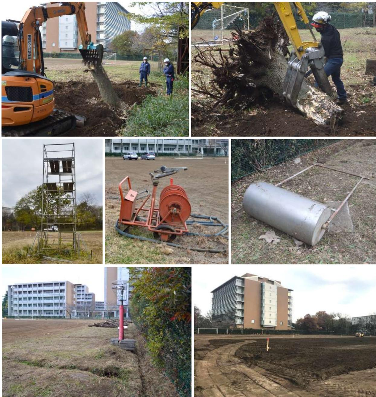
12月中旬、排水設備の改修工事が進む。サッカーグラウンドの外周に側溝が新設され、ほとんどが壊れて使えなくなっていた散水用のレインガンやスプリンクラーは撤去された。
